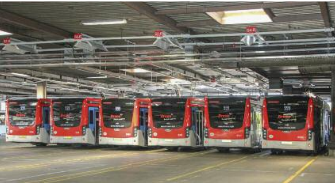
↑ Die Depothalle ist bereits auf kompletten E-Bus-Betrieb ausgelegt. Mit wenigen Nachrüstungen können dann 90 Einheiten von hier aus eingesetzt werden. Die roten Schilder über den Ladehauben zeigen übrigens Schnelllader an Fotos: Bünnagel
