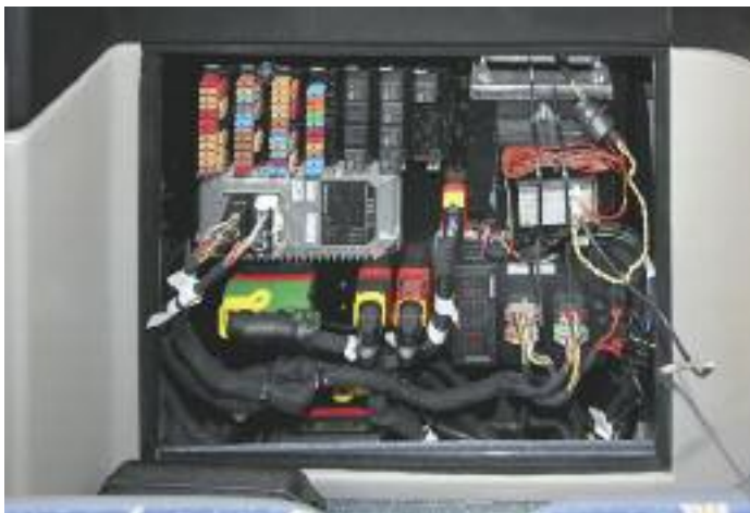
▲ Für die Datenauswertung unserer Testfahrt durch Bonn hatten wir kurzerhand die Elektronikschnittstelle angezapft
